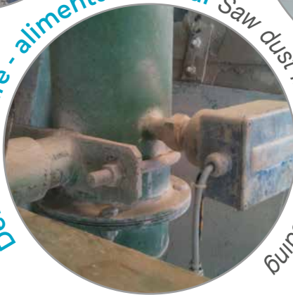
Débit charbon actif pour incinérateur Coal flow for incineration plant.
